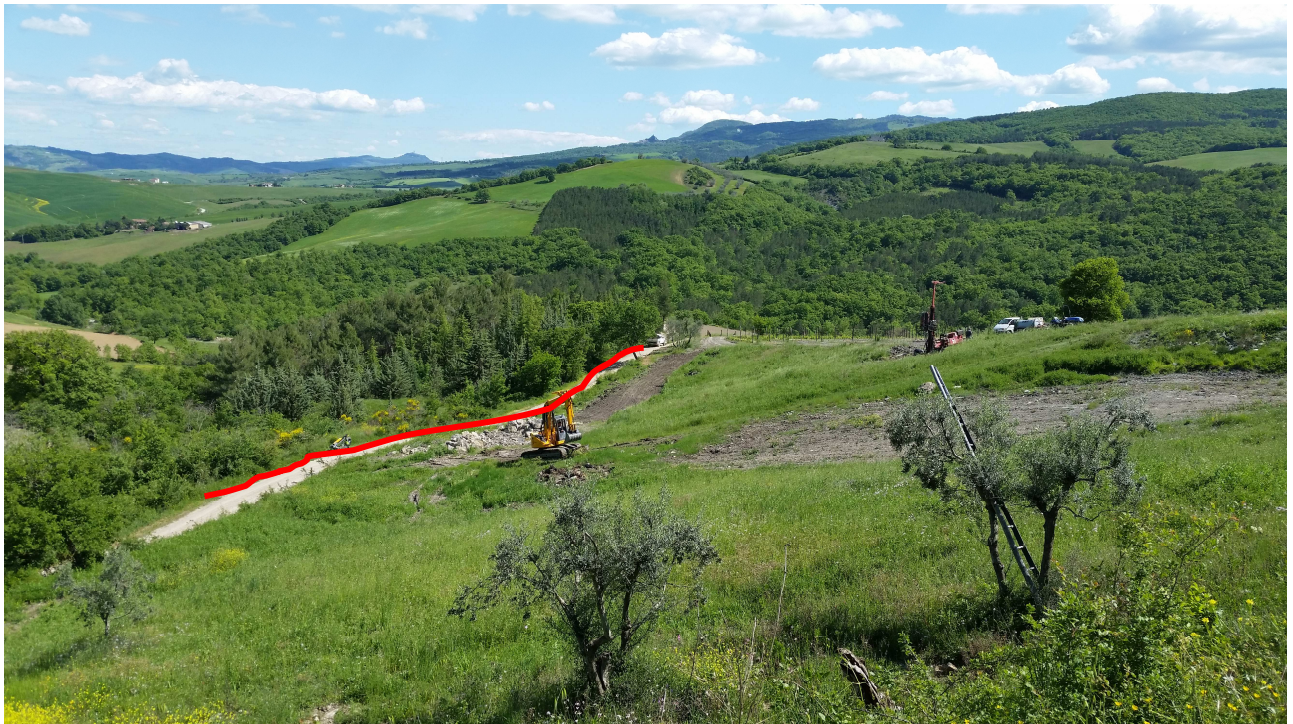
Foto 4 – Andamento ondulato della strada con evidenziato la porzione depressa in corrispondenza del settore centrale del versante
