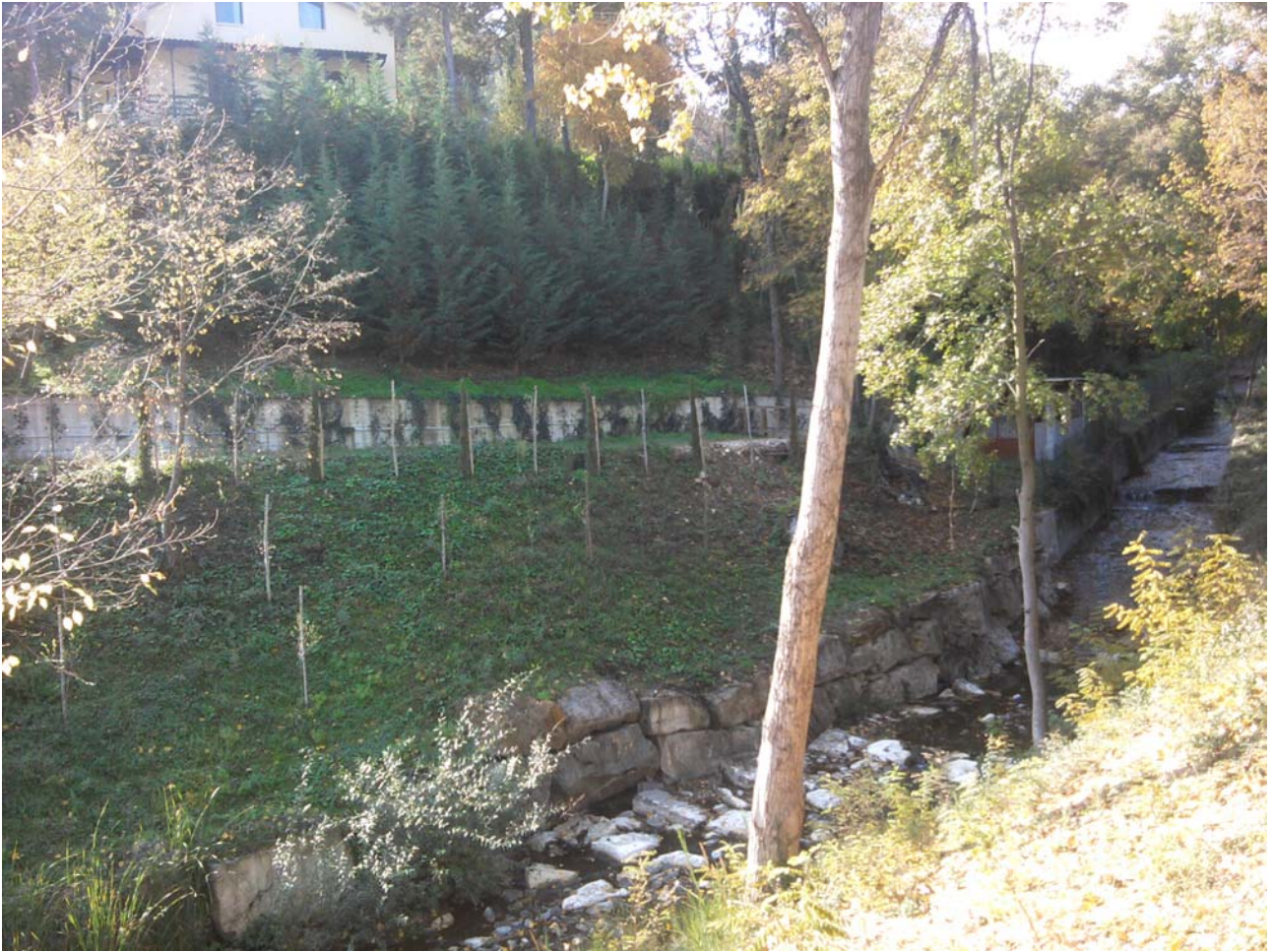
Foto 1: l'alveo del Torrente Rondinaia e, sullo sfondo in alto, la costruzione esistente all'interno della zona di piano; il dislivello è pari ad almeno 10 metri.
