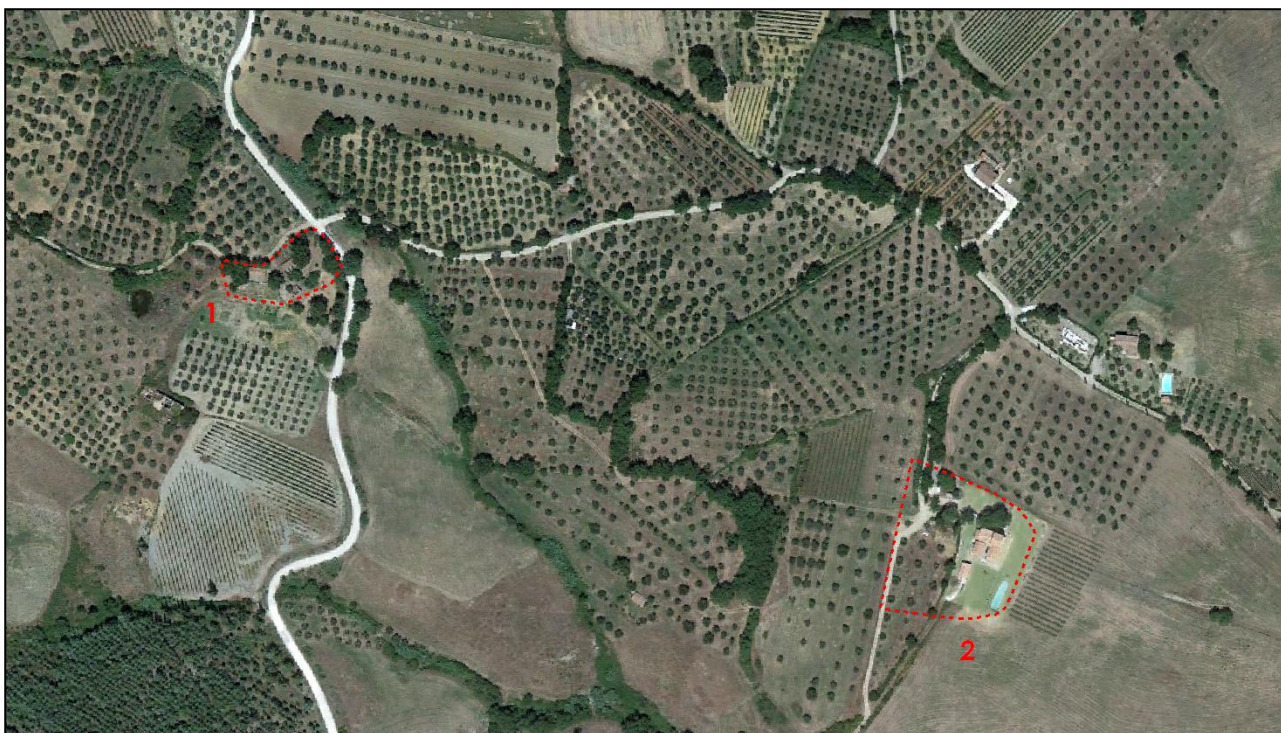
Fig. 2. Insediamenti interessati dal Piano di recupero. Vista zenitale dello stato di fatto 1 . Scala 1:2.000.
