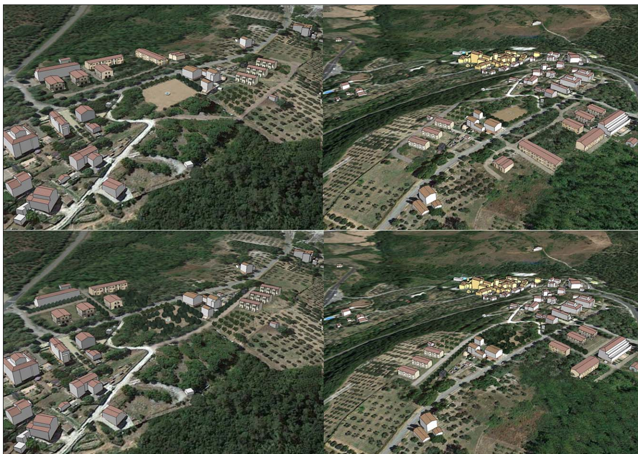
Vignone. Fotosimulazioni degli interventi previsti Ante e Post Conferenza di servizi. Vedute da nordest e da sudovest.
